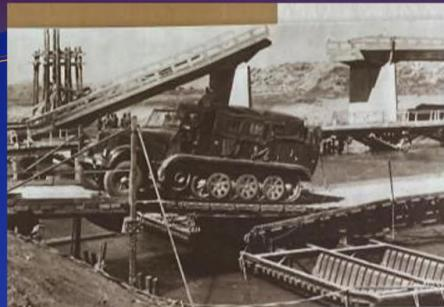
Εργαστηριό πολικό όχημα διέρκει την πρόκαιρη γέφυρα που κατασκευάζεται το πολικό Μηχανικό
